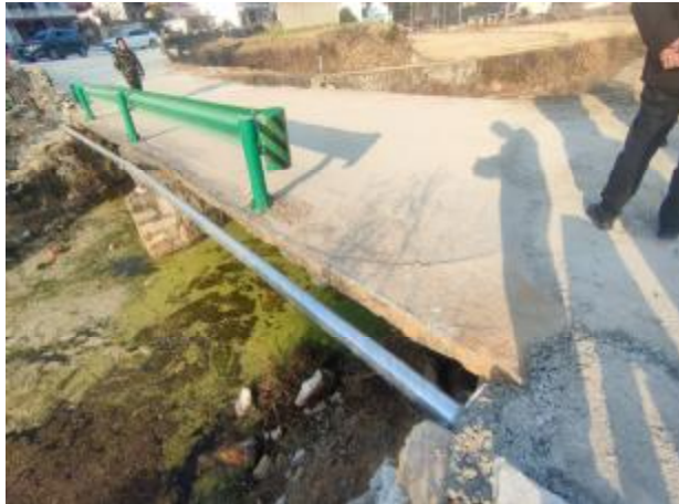
桥面梁板单薄，承载能力差
