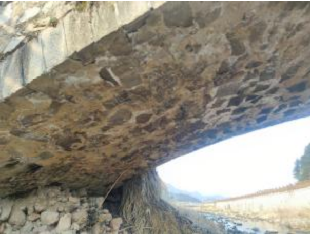
砌石松散、脱落
